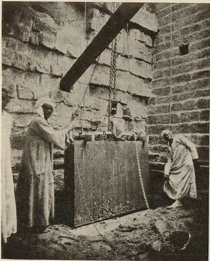
1. — Descente de la première palplanche.
